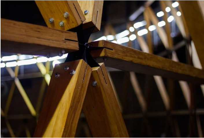
Figura 10: Conexão dos vértices
