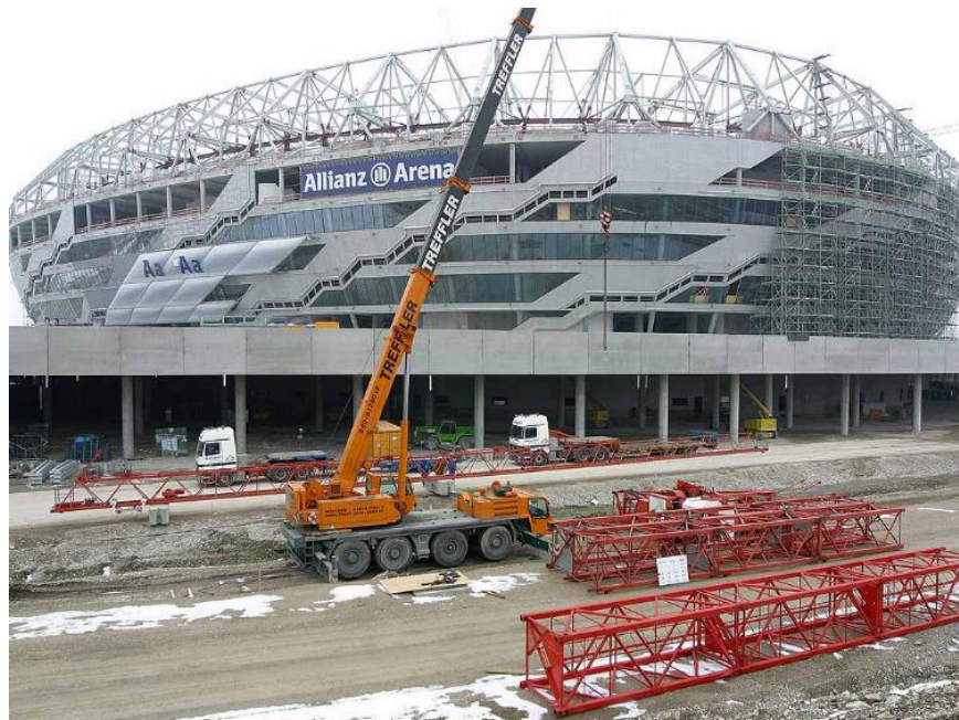
Figura 14: Construção - Estádio Allianz Arena
