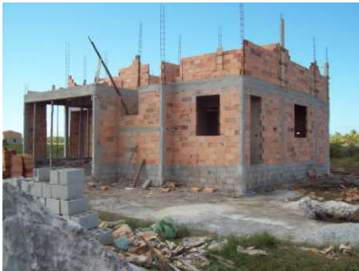
Figura 10: Construção a base de alvenaria
