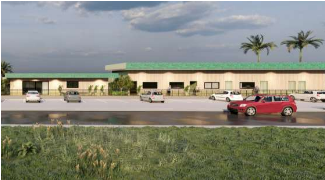
Figura 43: Fachada setor administrativo e comercial
