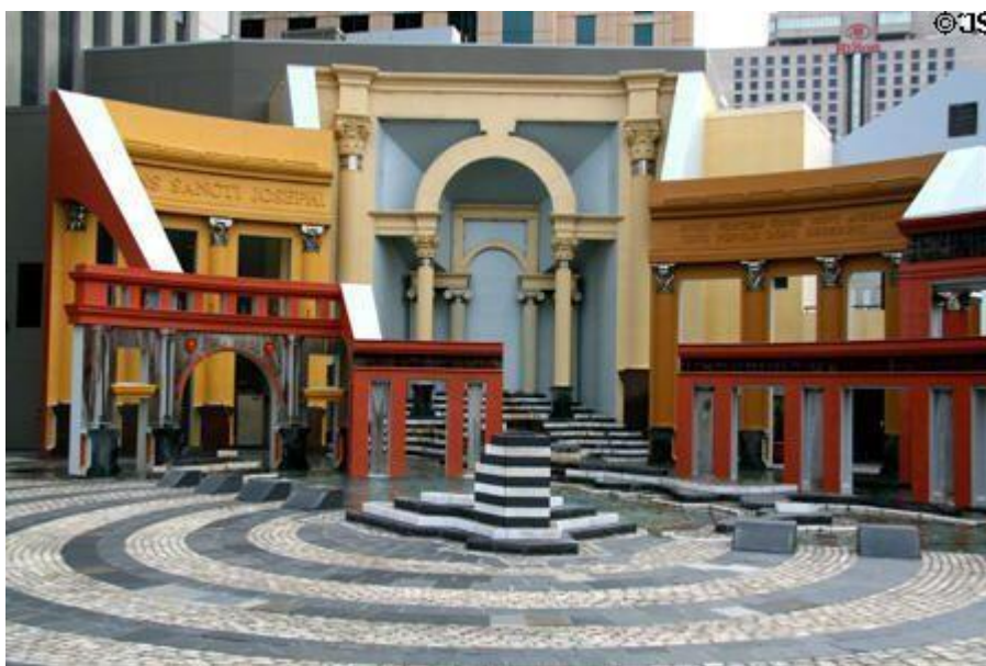
Figura 06: Edifício Piazza d'Italia em Nova Orleans
