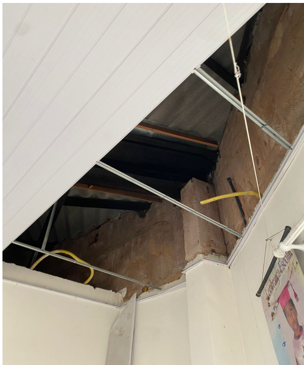
Figura 35 - Estado do Forro dentro da unidade
