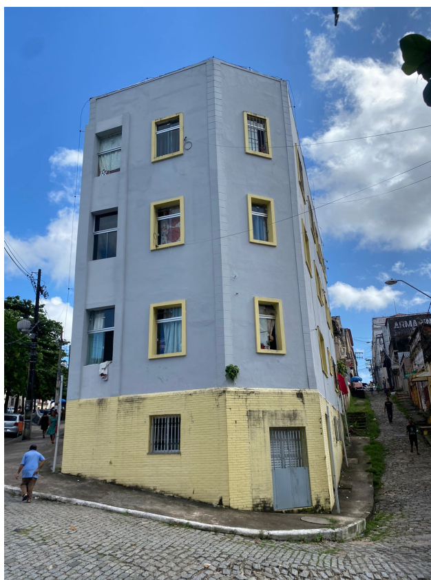
Figura 27 - Vista lateral da edificação.
