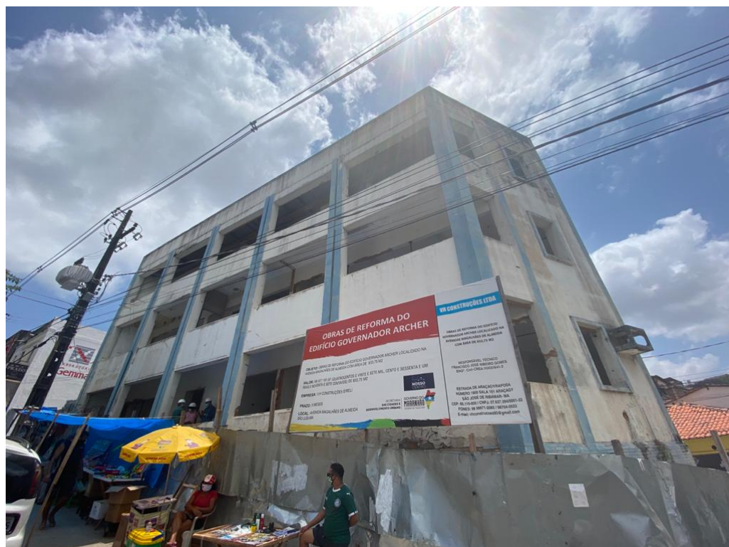
Figura 19 - Edifício Governador Archer durante reforma.
