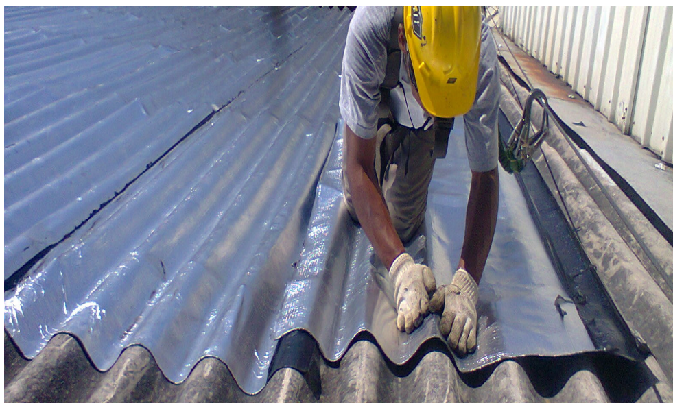
Figura 42 - Aplicação de Manta Asfáltica em Cobertura.
