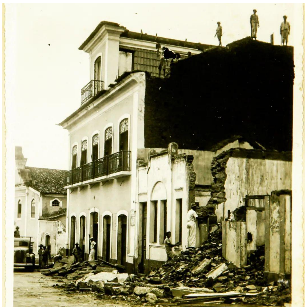
Figura 12 - Demolições para alargamento das ruas e avenidas.
