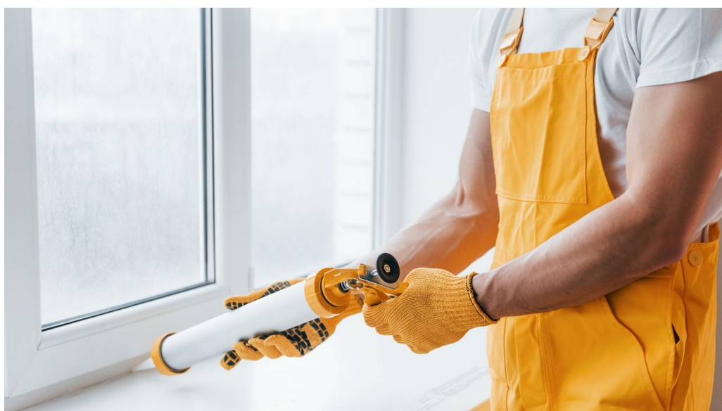
Figura 43 - Aplicação de Selante de Silicone
